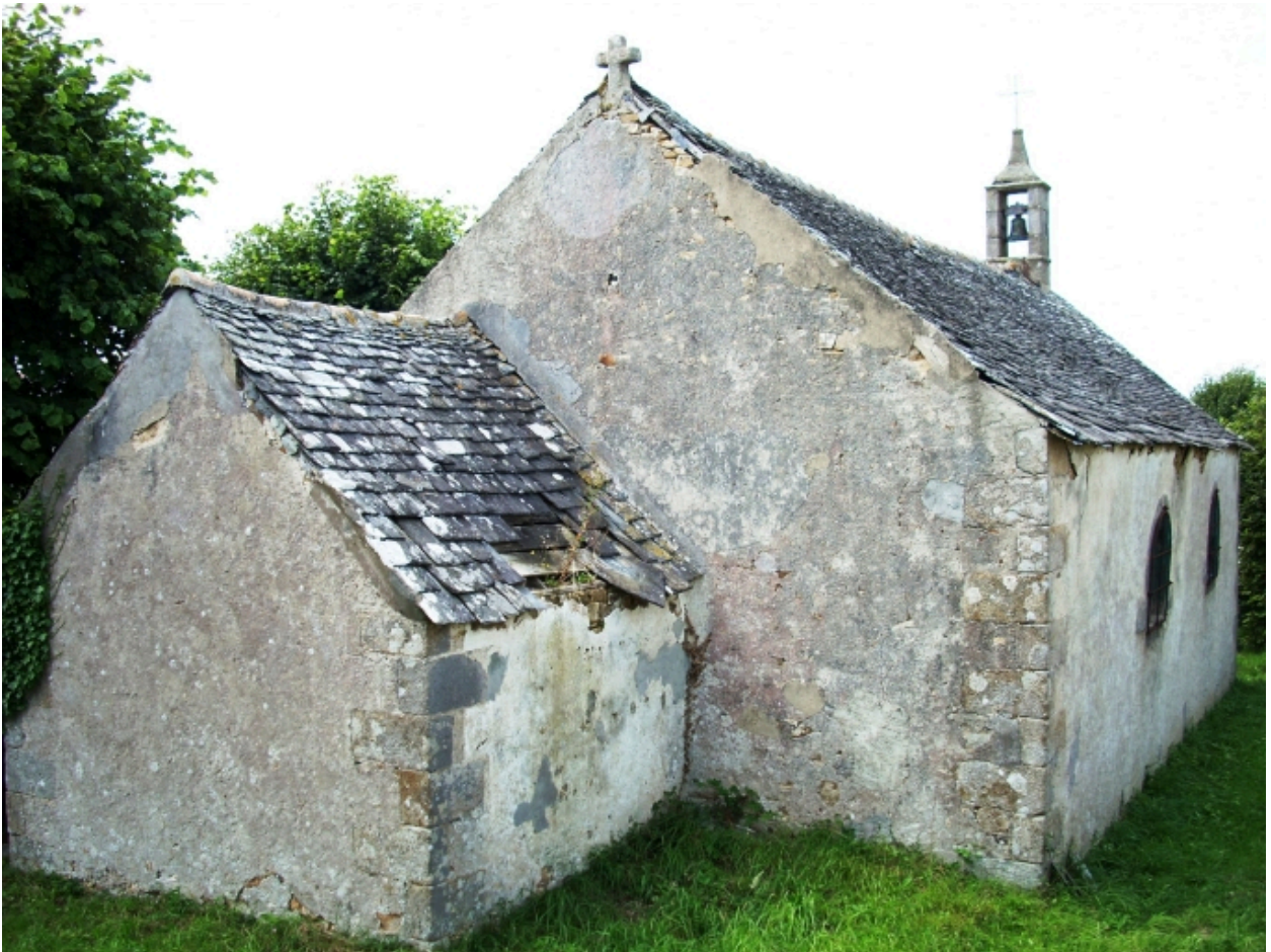
Plourin-lès-Morlaix, chapelle Saint-Michel : vue générale nord-est
