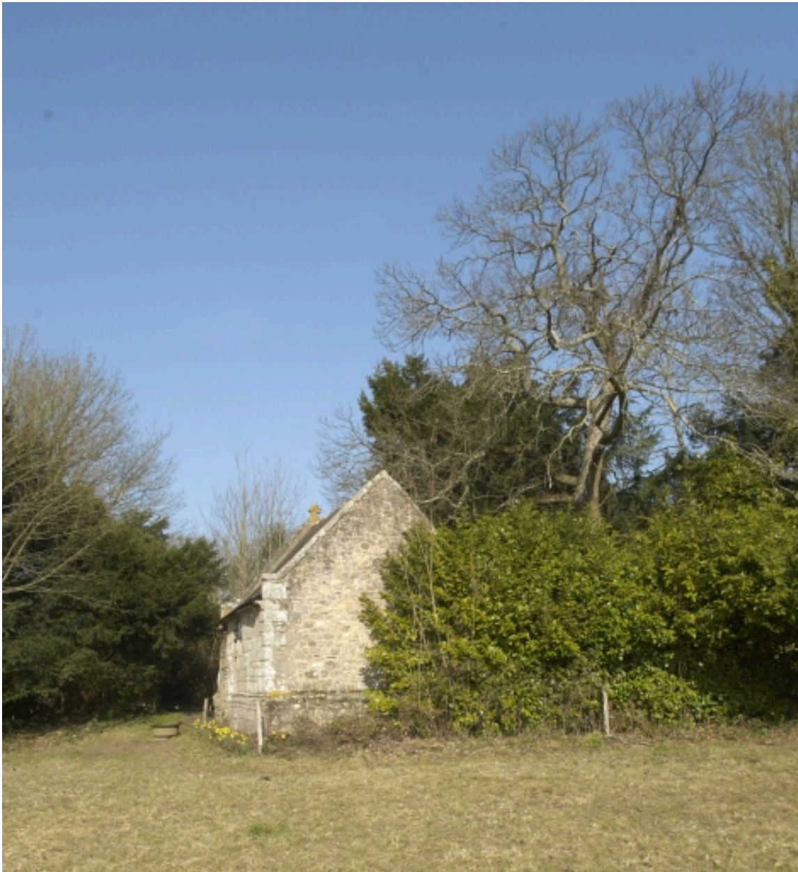
Vue arrière de la chapelle
