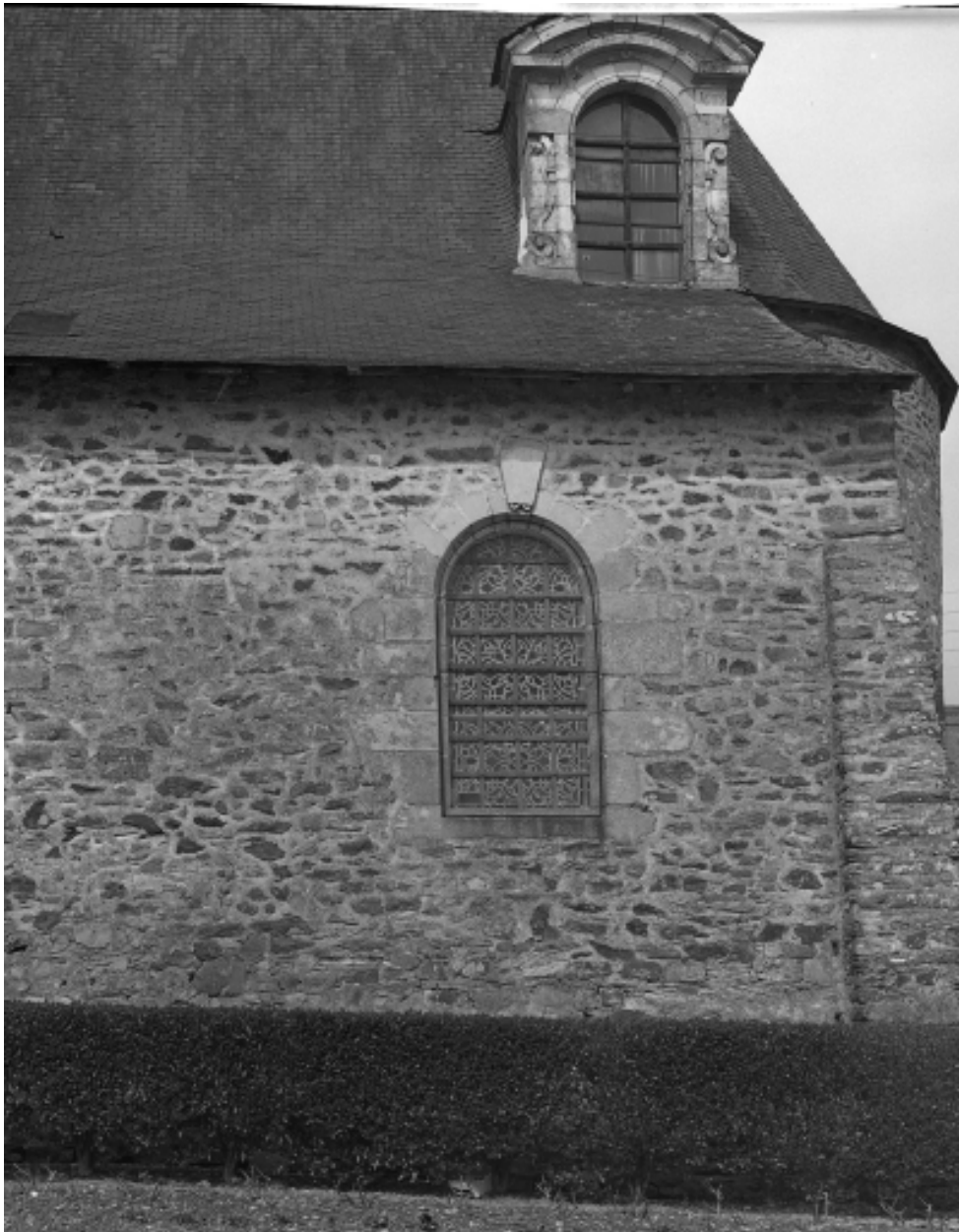
Façade sud, fenêtre est.
