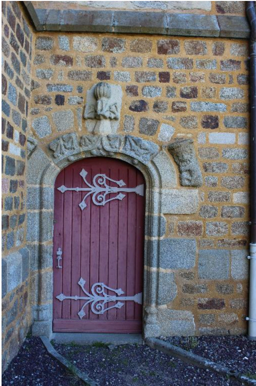
Détail de la porte du bras sud du transept
