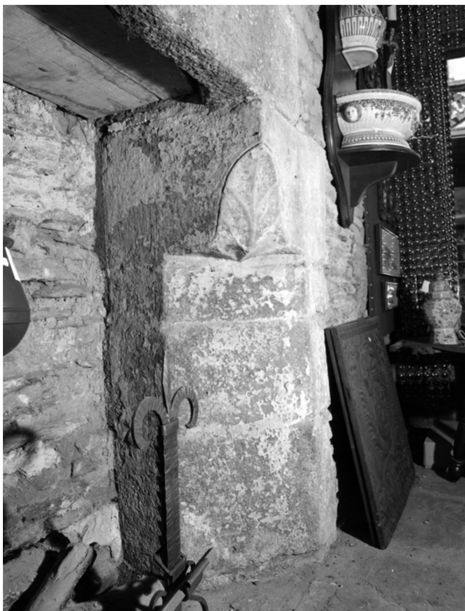
15 rue du fil, cheminée, détail.
