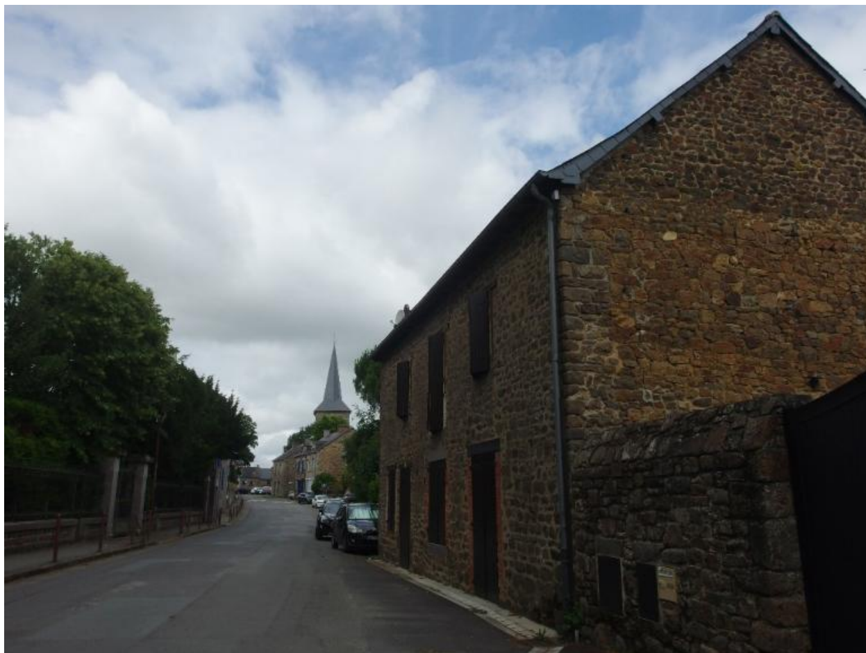
Vue de la façade sud
