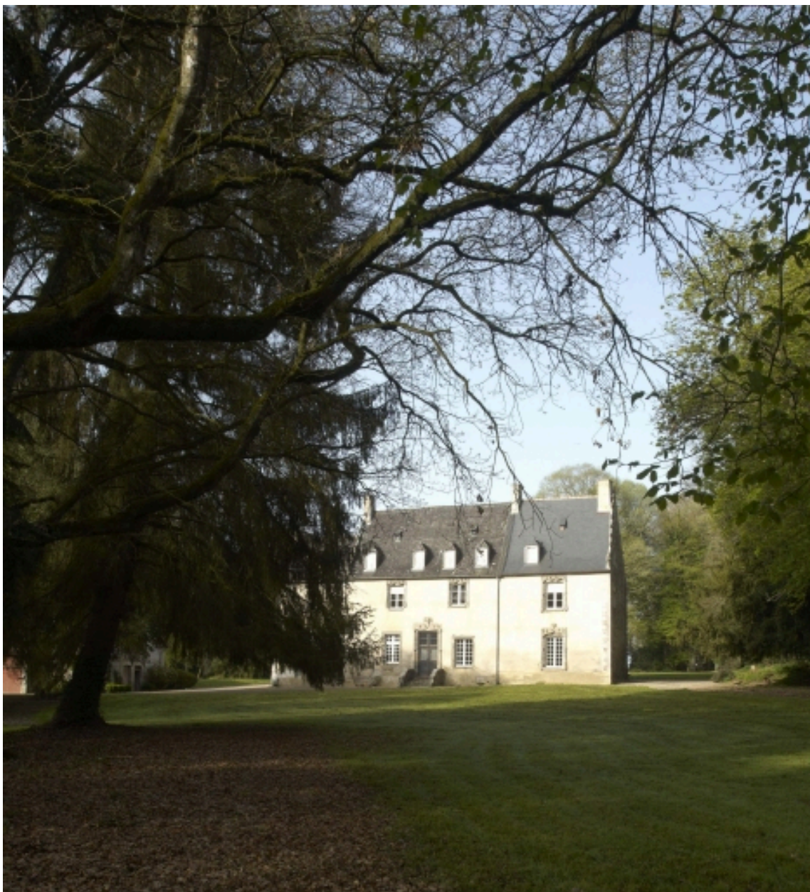
Logis, vue générale
