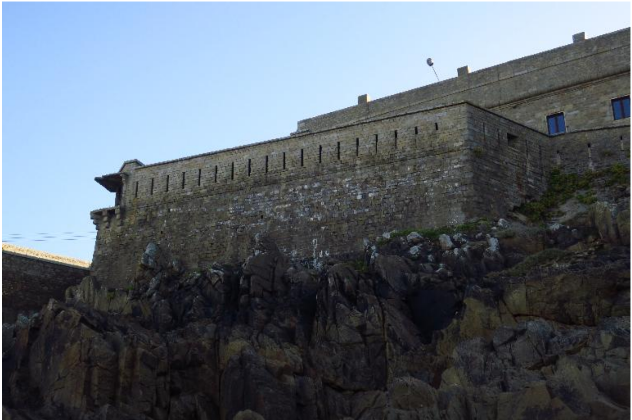
Saint-Pierre-Quiberon, fort de Penthievre, enceinte, escarpe du réduit.
