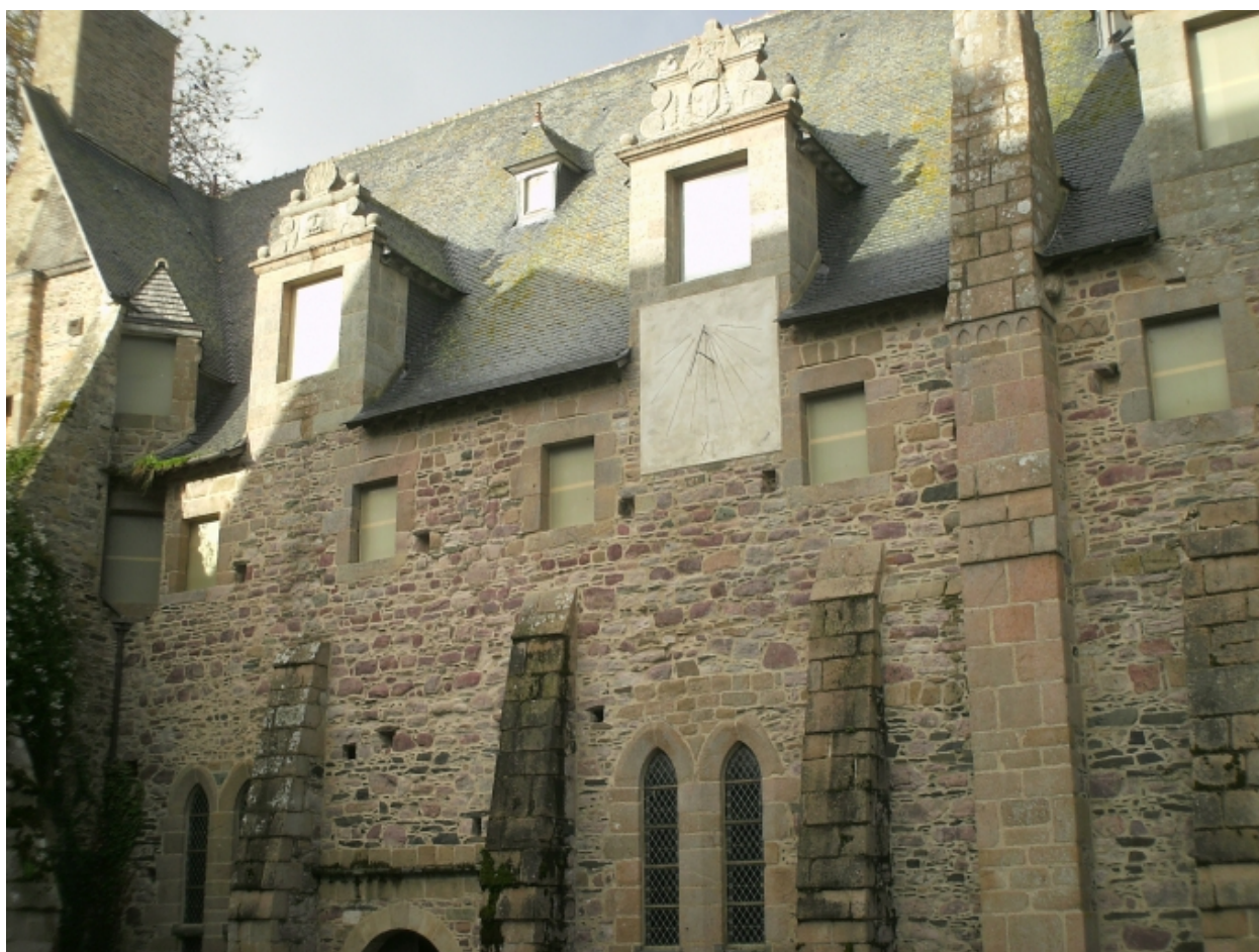
Le bâtiment abritant la salle au Duc, façade sud
