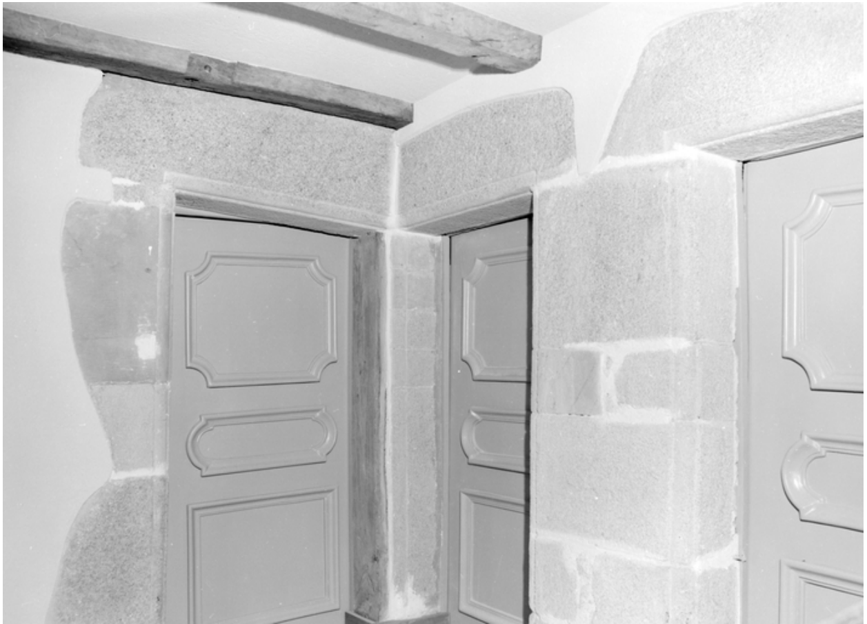
Maison : le palier de l'étage (état en 1985)
