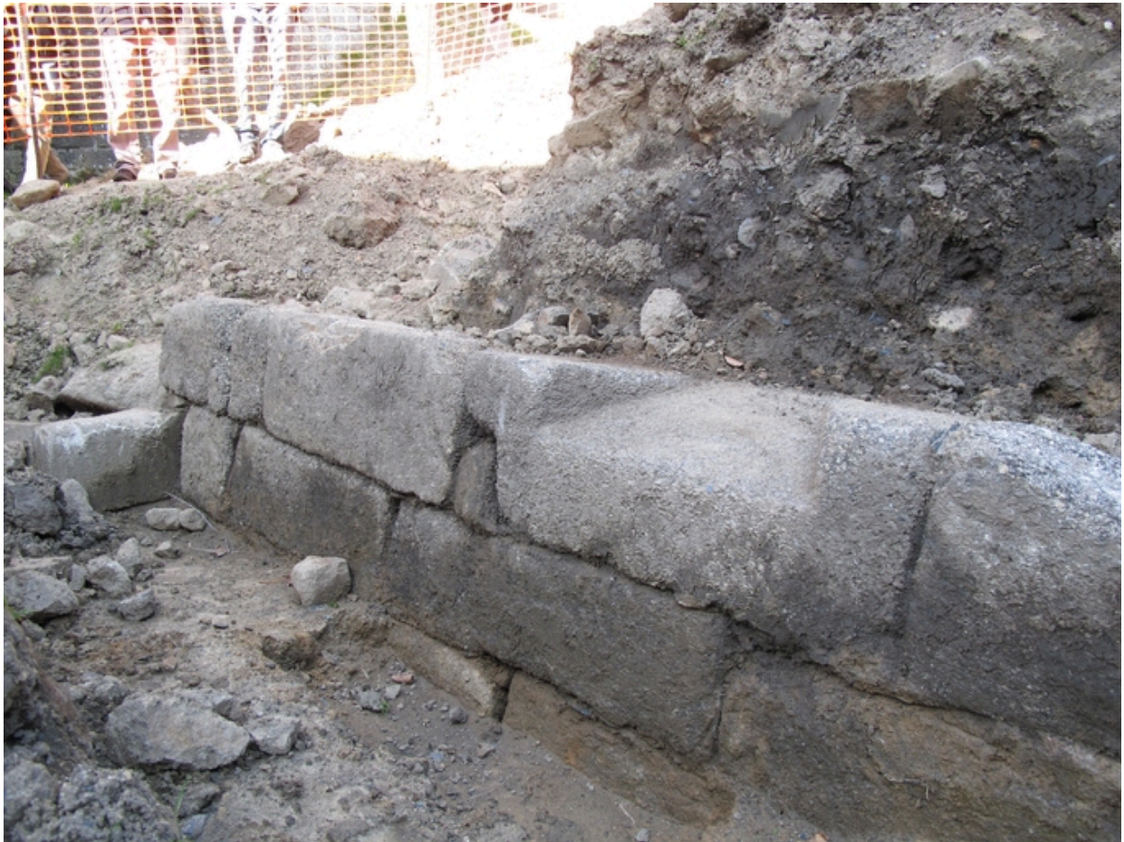
Vue des sondages archéologiques dans la basse-cour : vestiges d'une barbacane, ouverture de tir (Service régional de l'archéologie, Yves Roumegoux, 16 février 2011)
