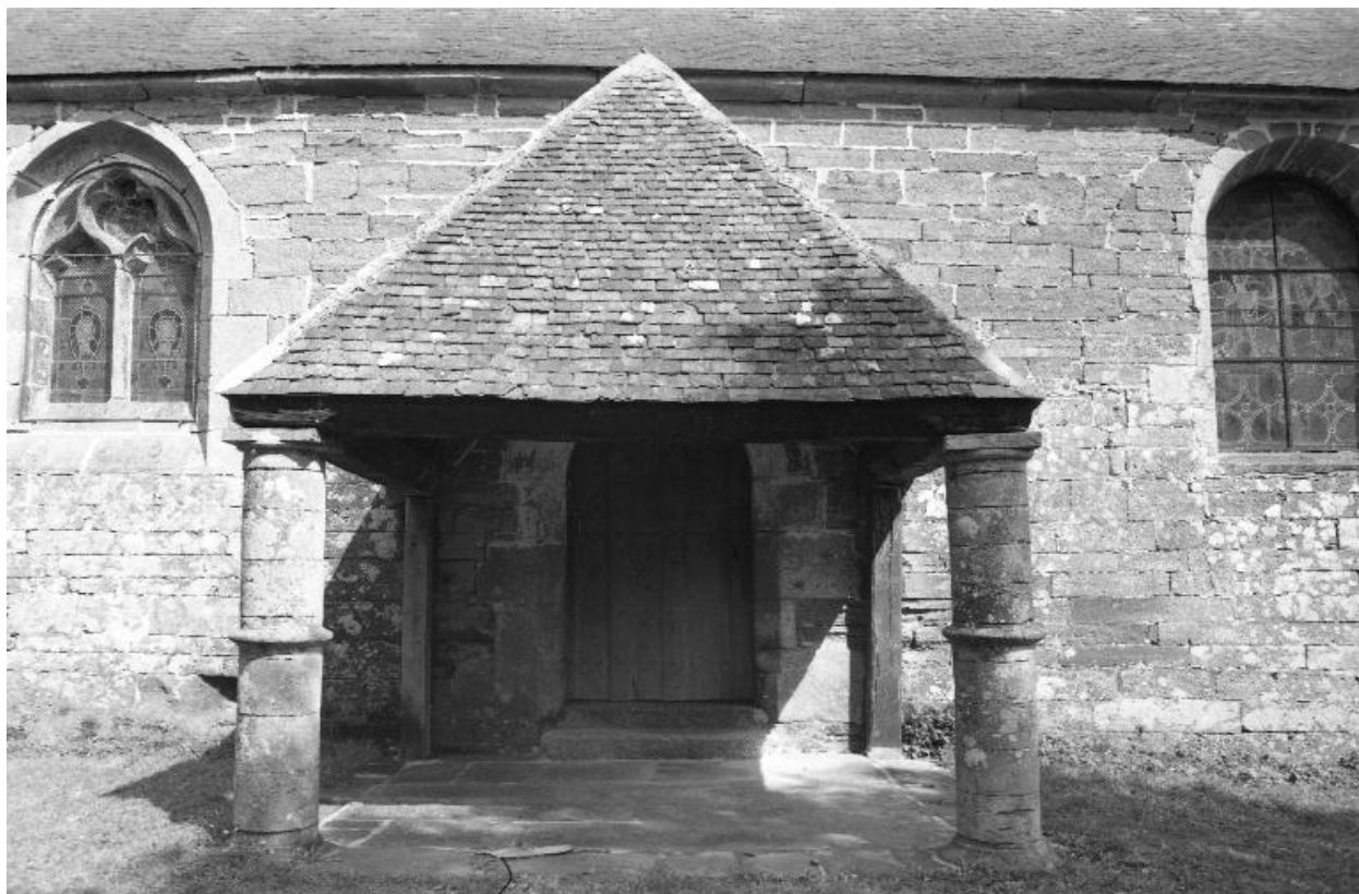
Elévation du porche sur la façade sud.
