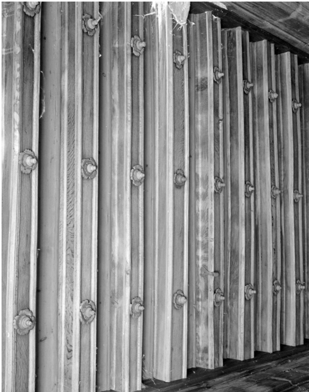
Chambre à l'étage : détail du plafond.
