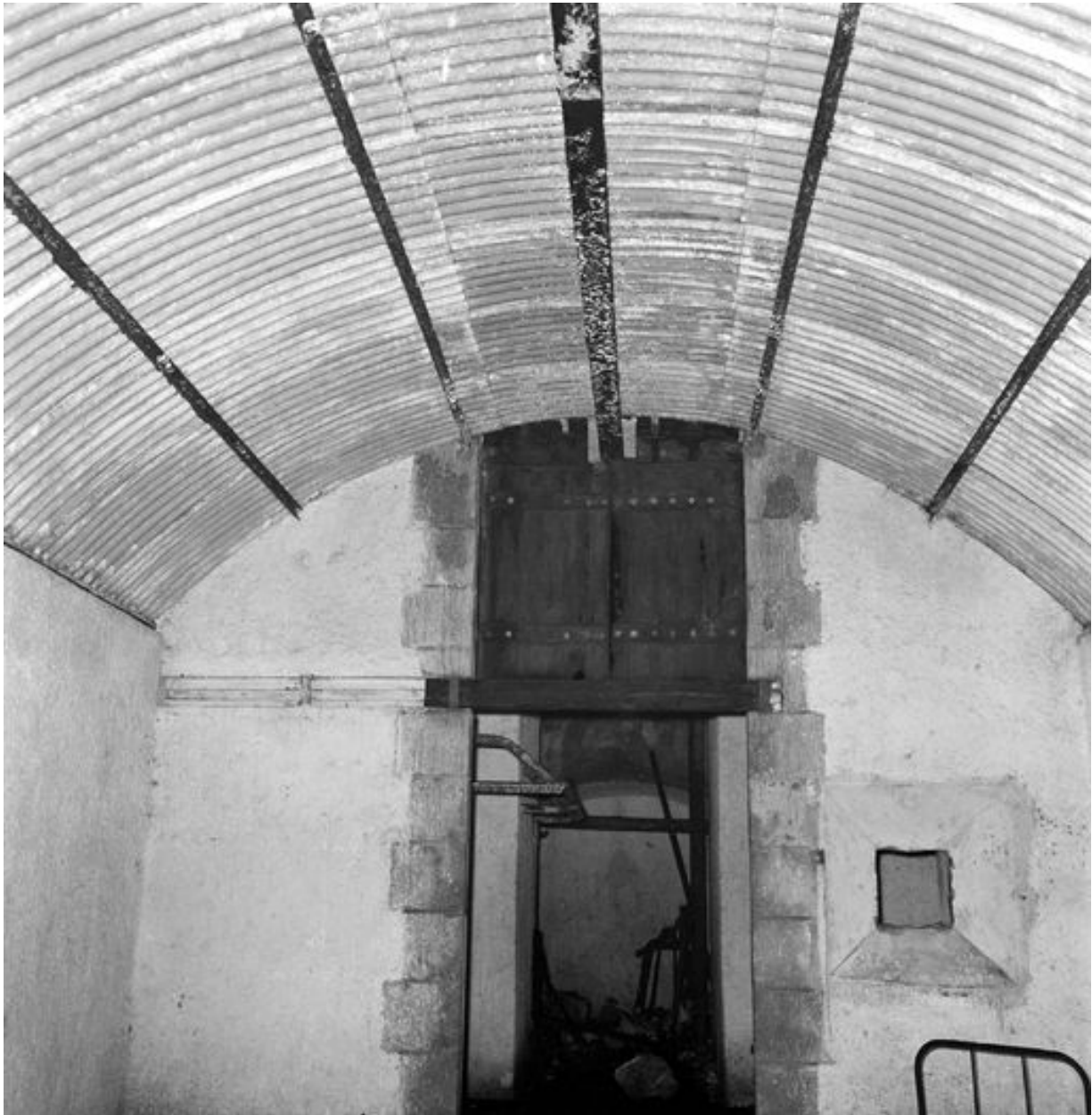
Vue de la batterie du Toulinguet en 1969 : magasin à poudre sous roc doublé de tôle-parapluie. A droite : fenêtre à lanterne / créneau de lanterne. A signaler : huisserie en place
