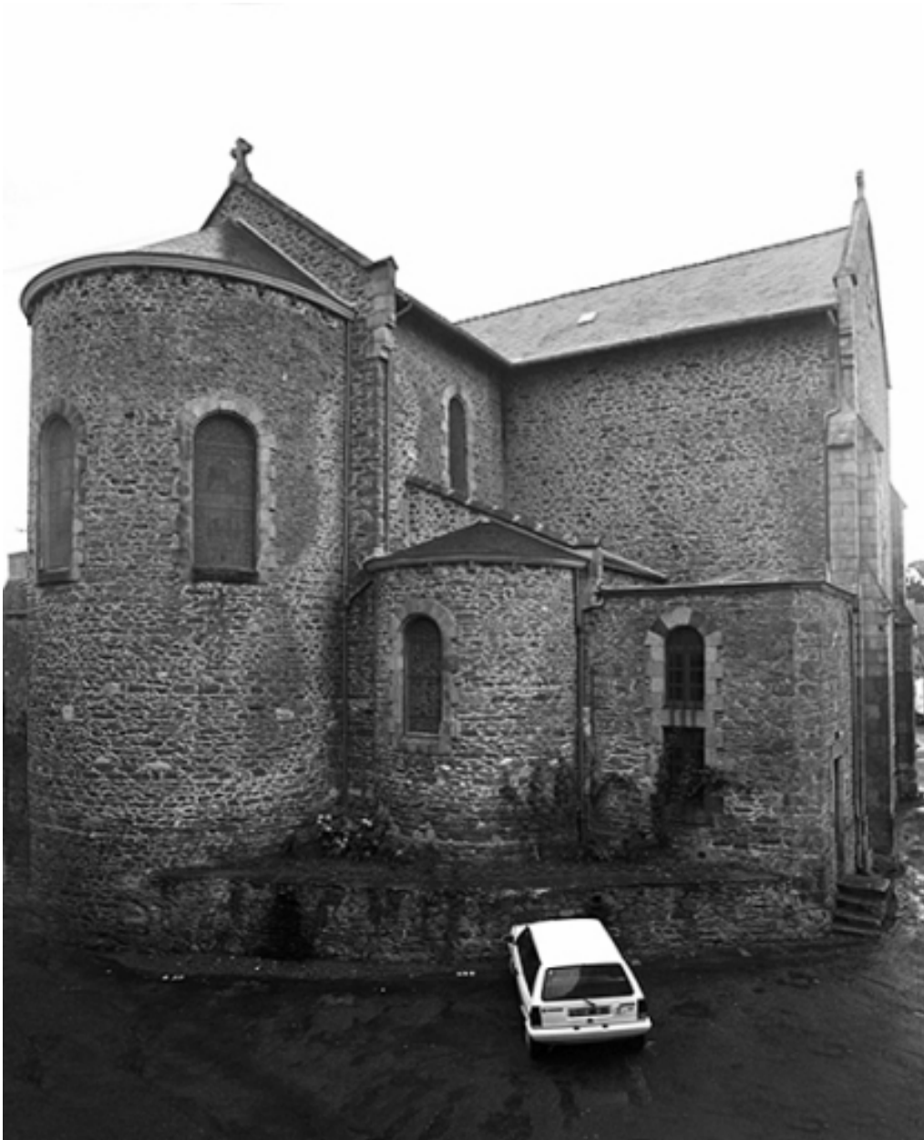
Vue générale nord-est
