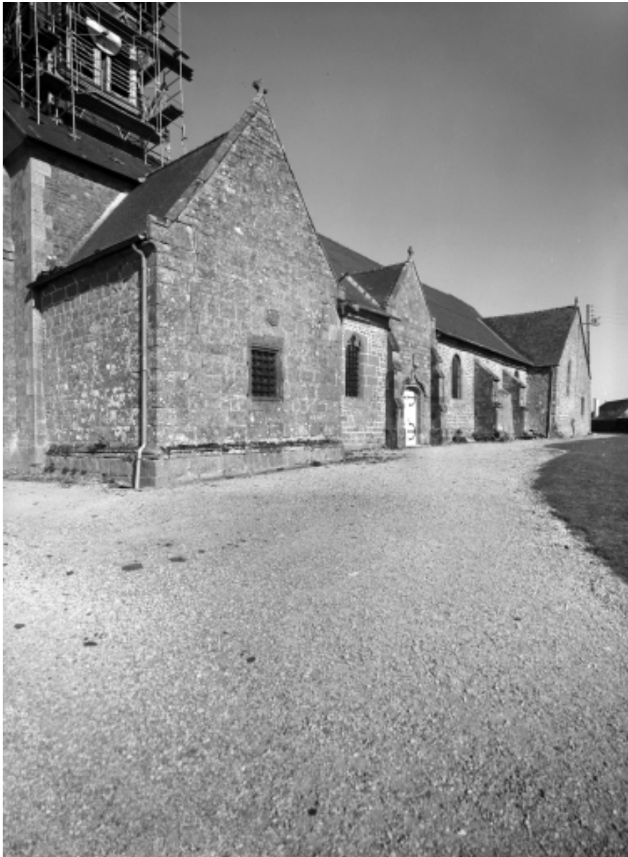
Elévation Sud : vue générale
