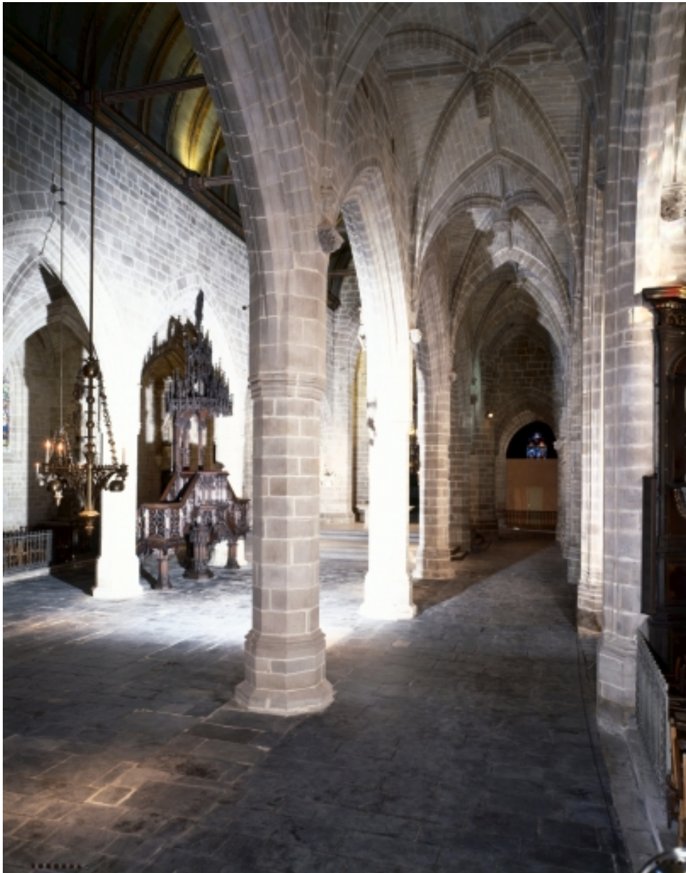
Vue d'un collatéral.
