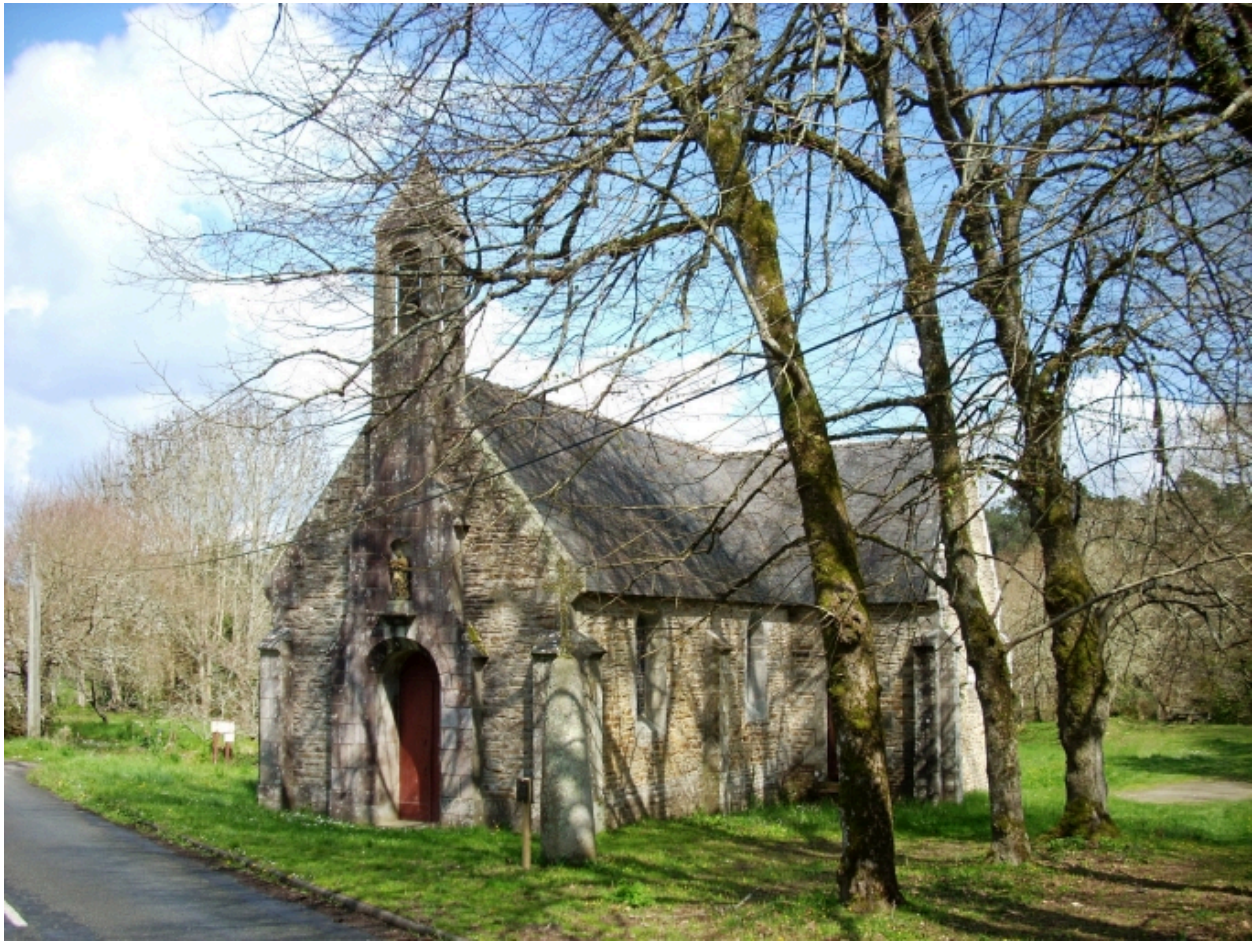
Moëlan-sur-Mer, chapelle de Lanriot : vue générale sud-ouest
