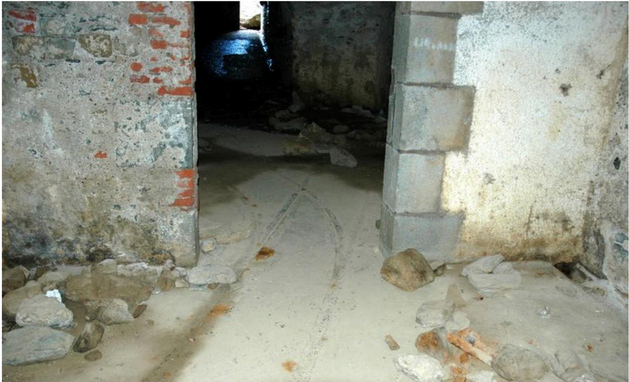
Vue du couloir d'accès à la chambre de tir et au magasin à munitions : la voie ferrée permettait l'emploi d'un wagonnet pour la manutention des munitions (état en 2005)
