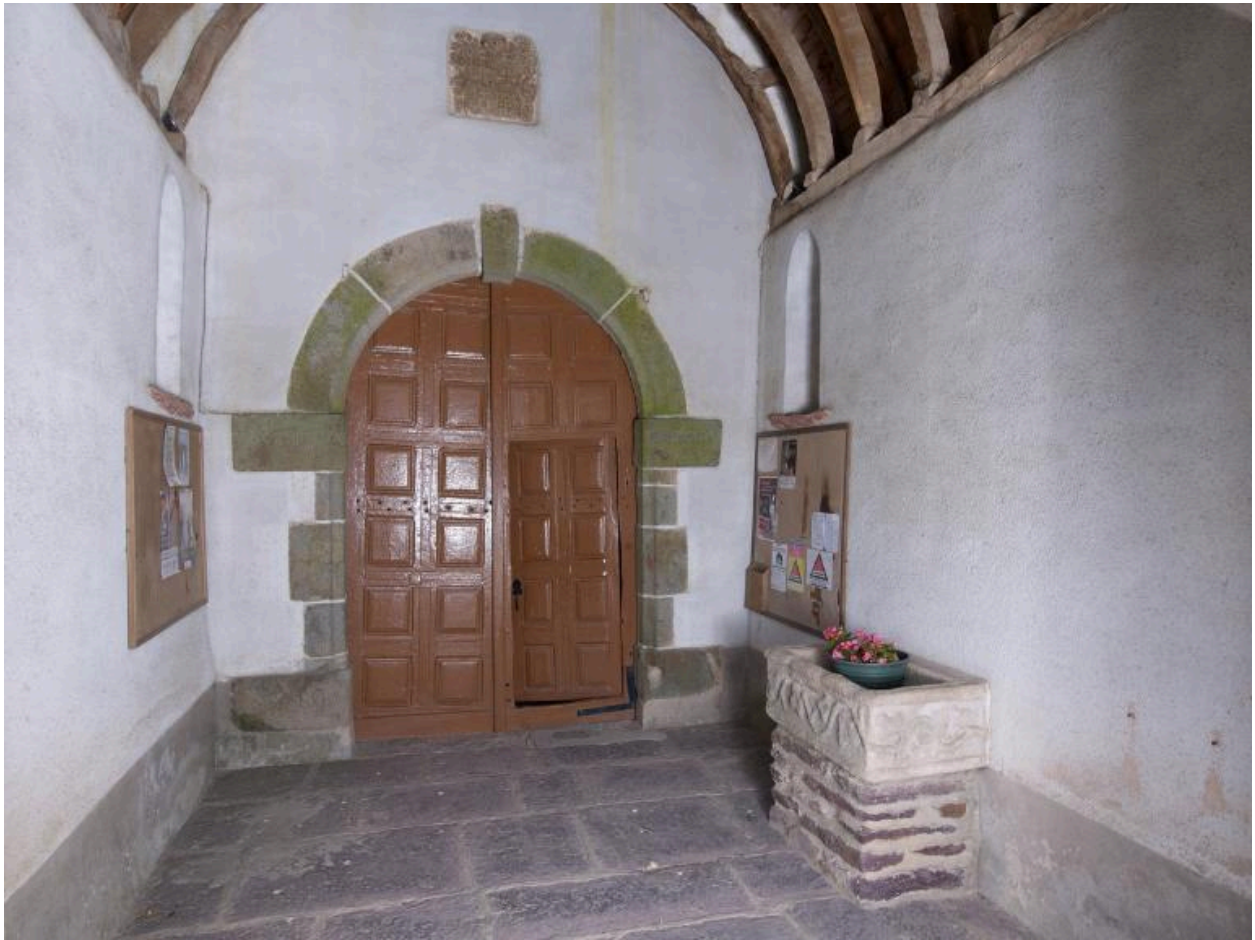
Porche ouest : vue générale
