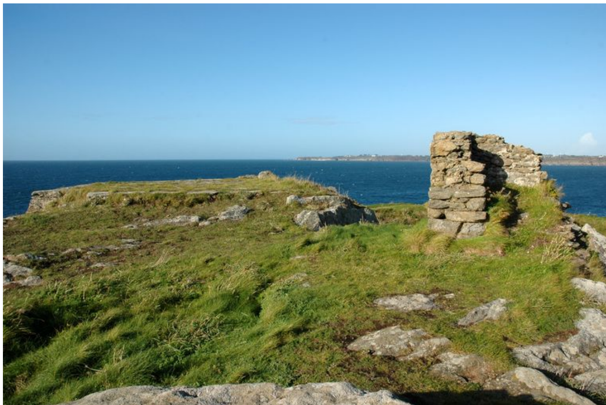
Vue générale de la plate-forme et de la guérite vers le nord (état en 2004)
