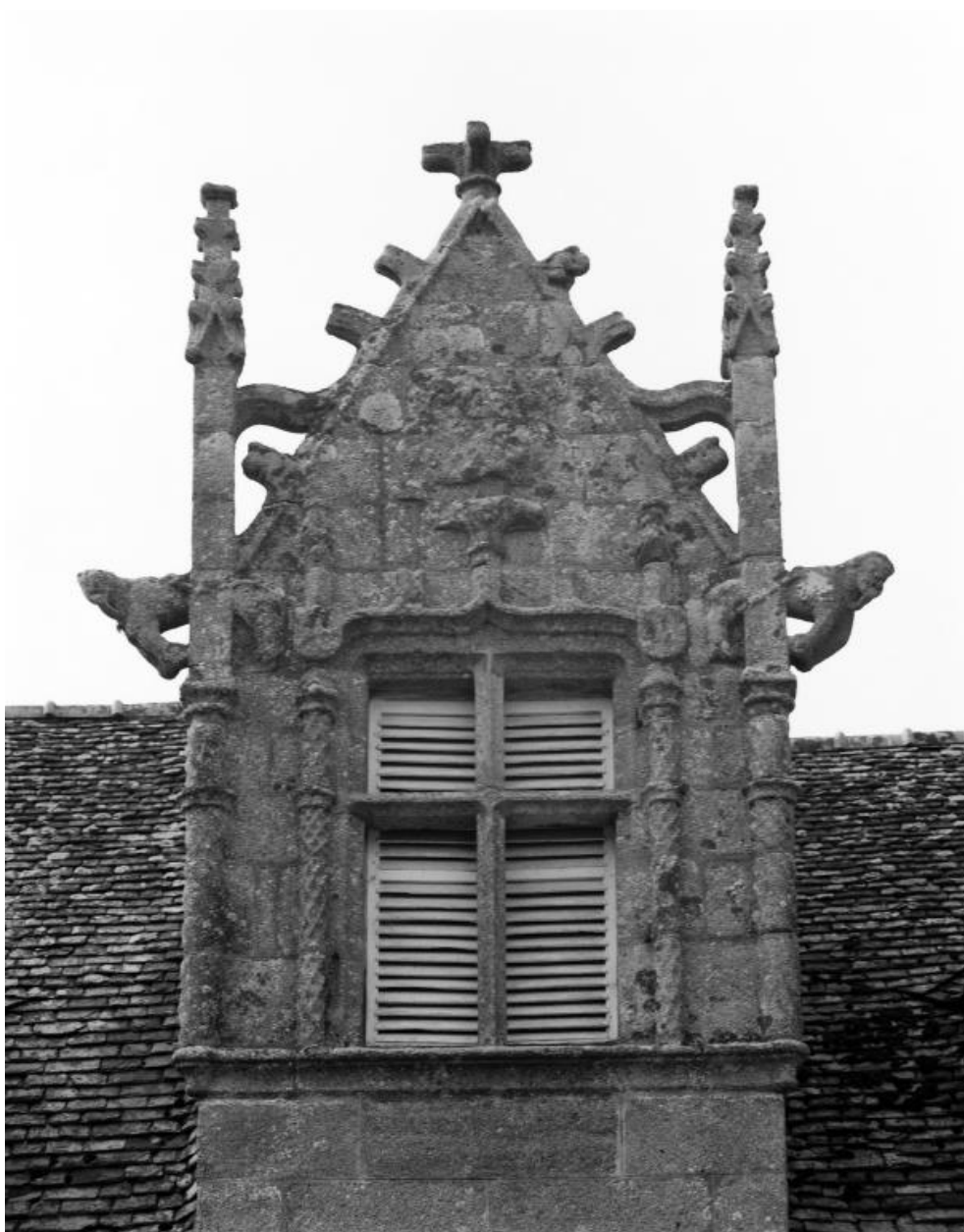
Façade sud-est, détail lucarne
