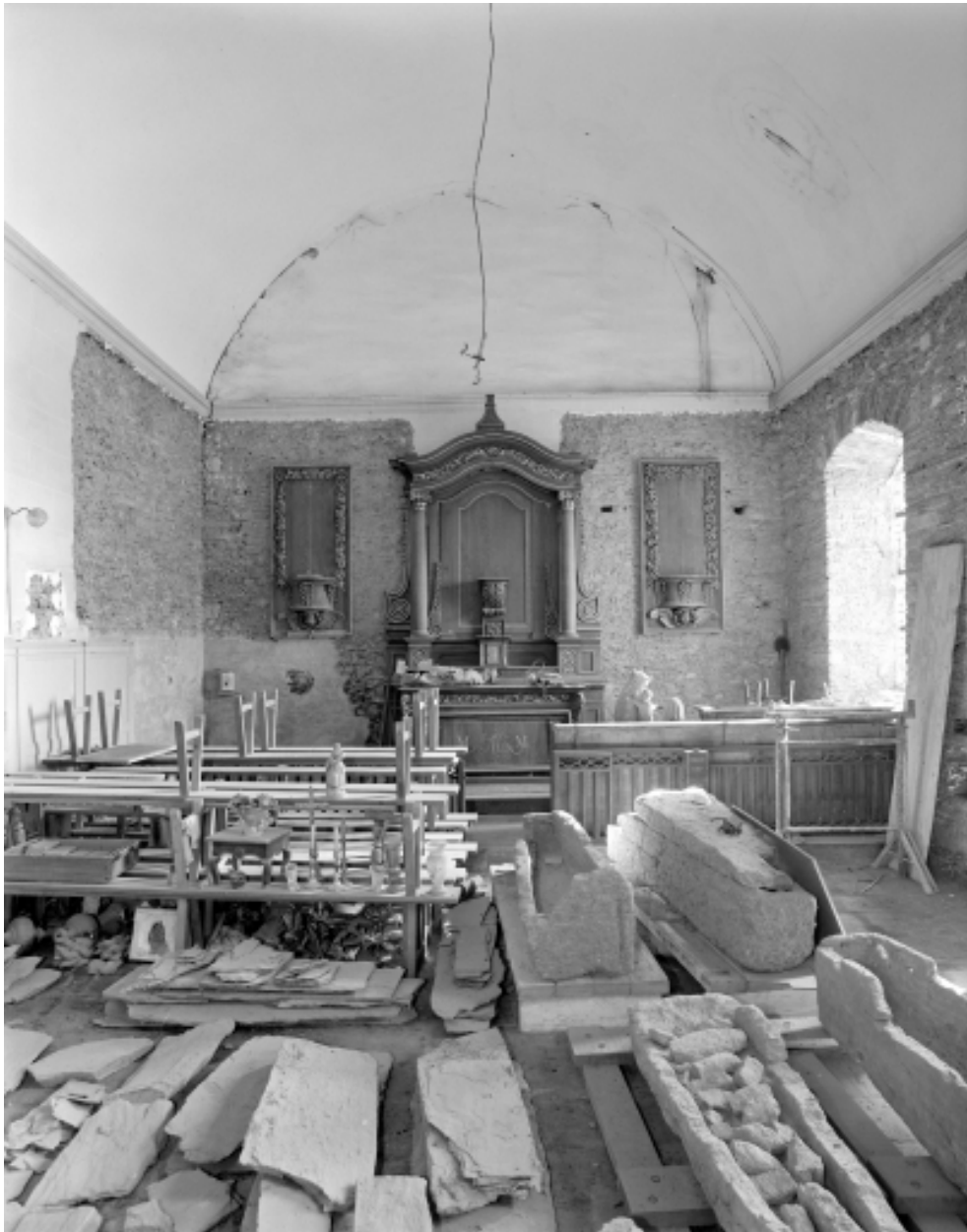
Intérieur : vue générale vers le chœur
