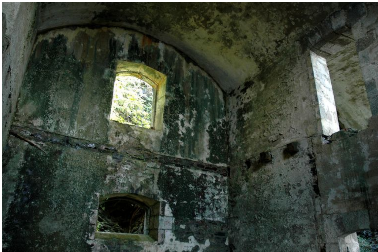
Vue de la caserne défensive Robert : première salle voûtée
