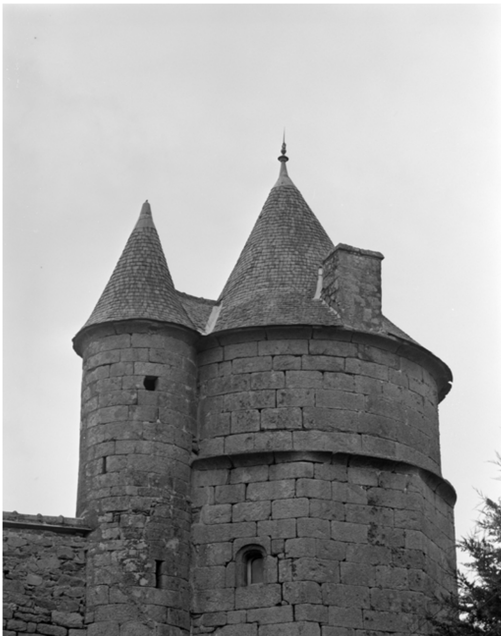
Façade est : haut de la tour et détail de la tourelle en encorbellement
