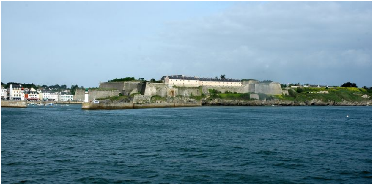
Vue générale de la citadelle de Belle-île
