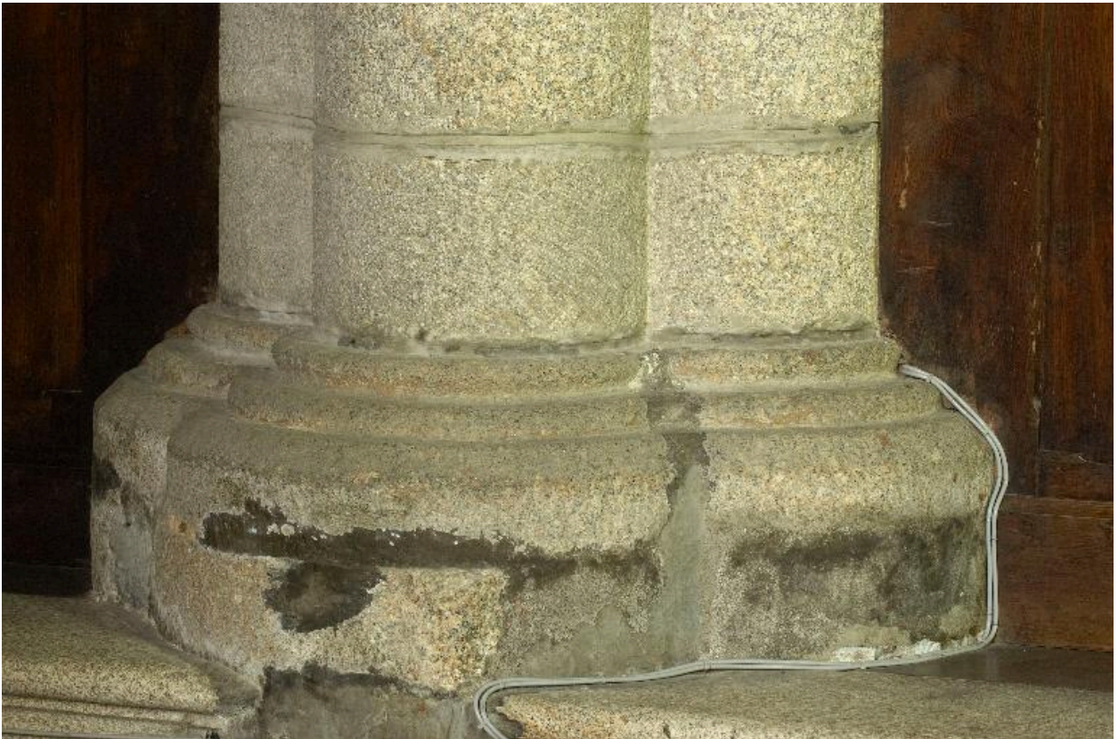
Bases des piles du choeur
