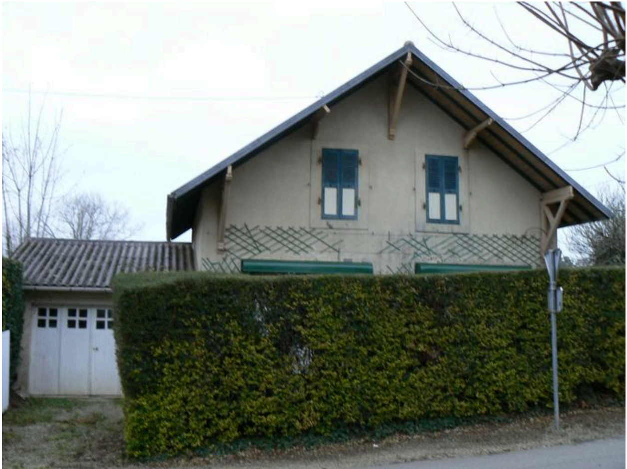
Vue générale de la villa Malakoff
