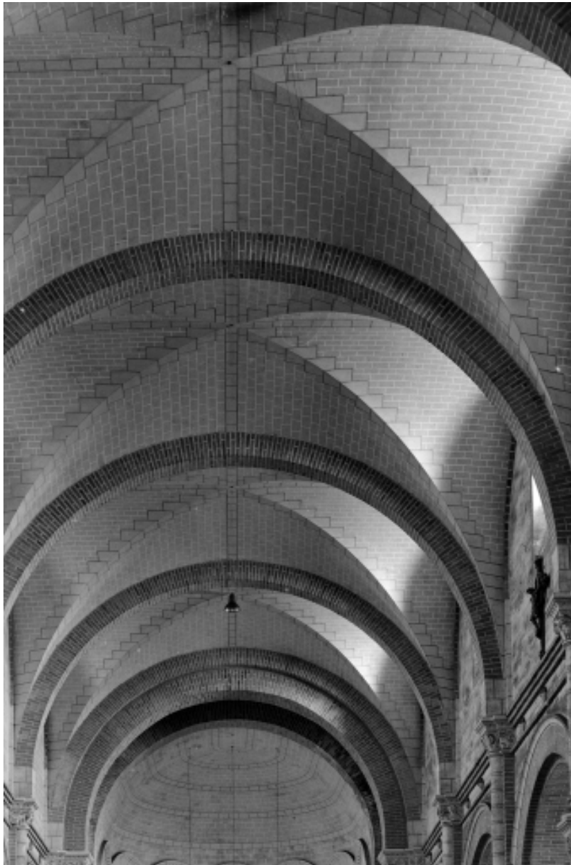
Voûtement de la nef, vue générale.
