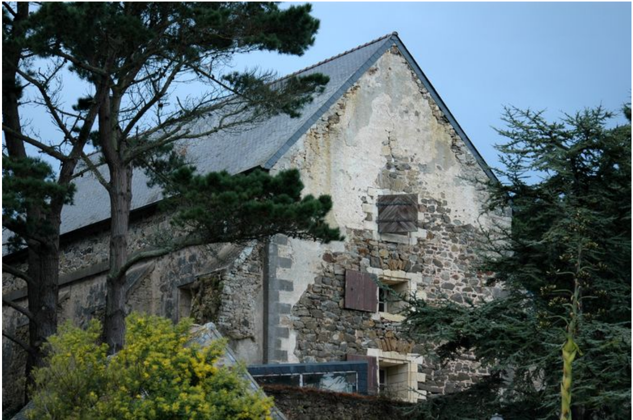
Vue du magasin à poudre à travers les arbres : pignon oriental et mur sud (état en 2004)
