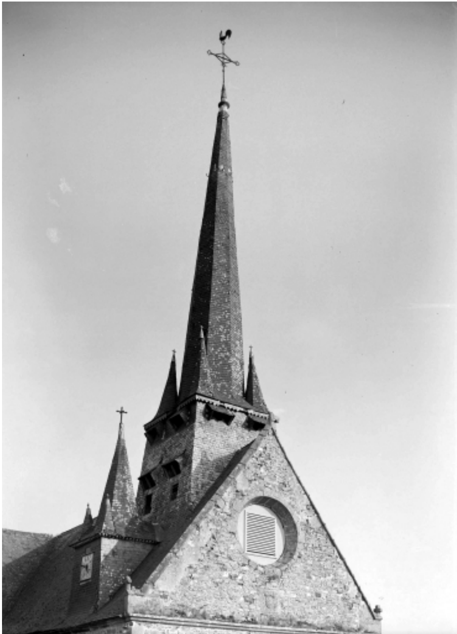
Elévation est, clocher : vue générale.
