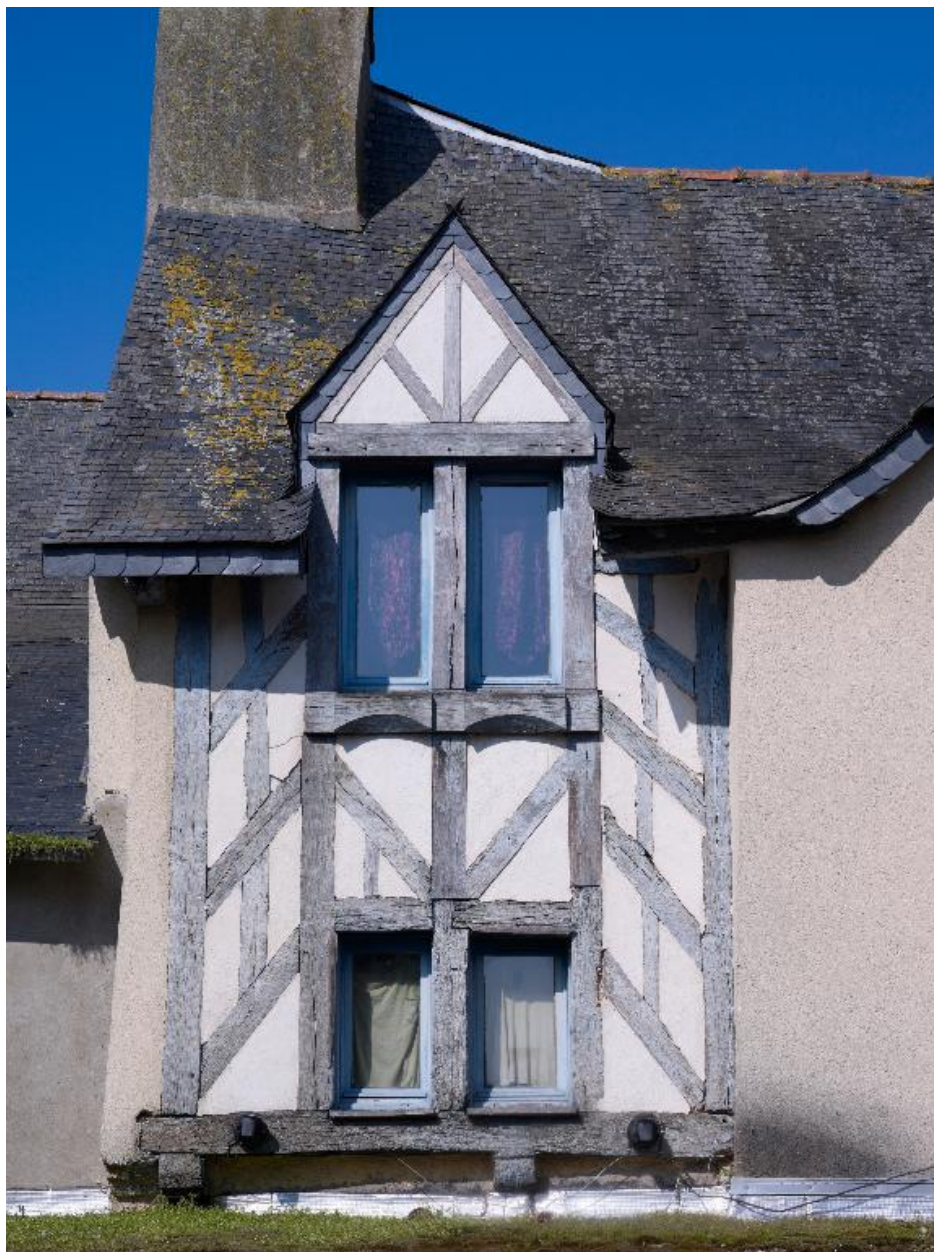
Maison, élévation donnant sur la rue Saint-Pierre : fenêtres et pan de bois (état en 2011)
