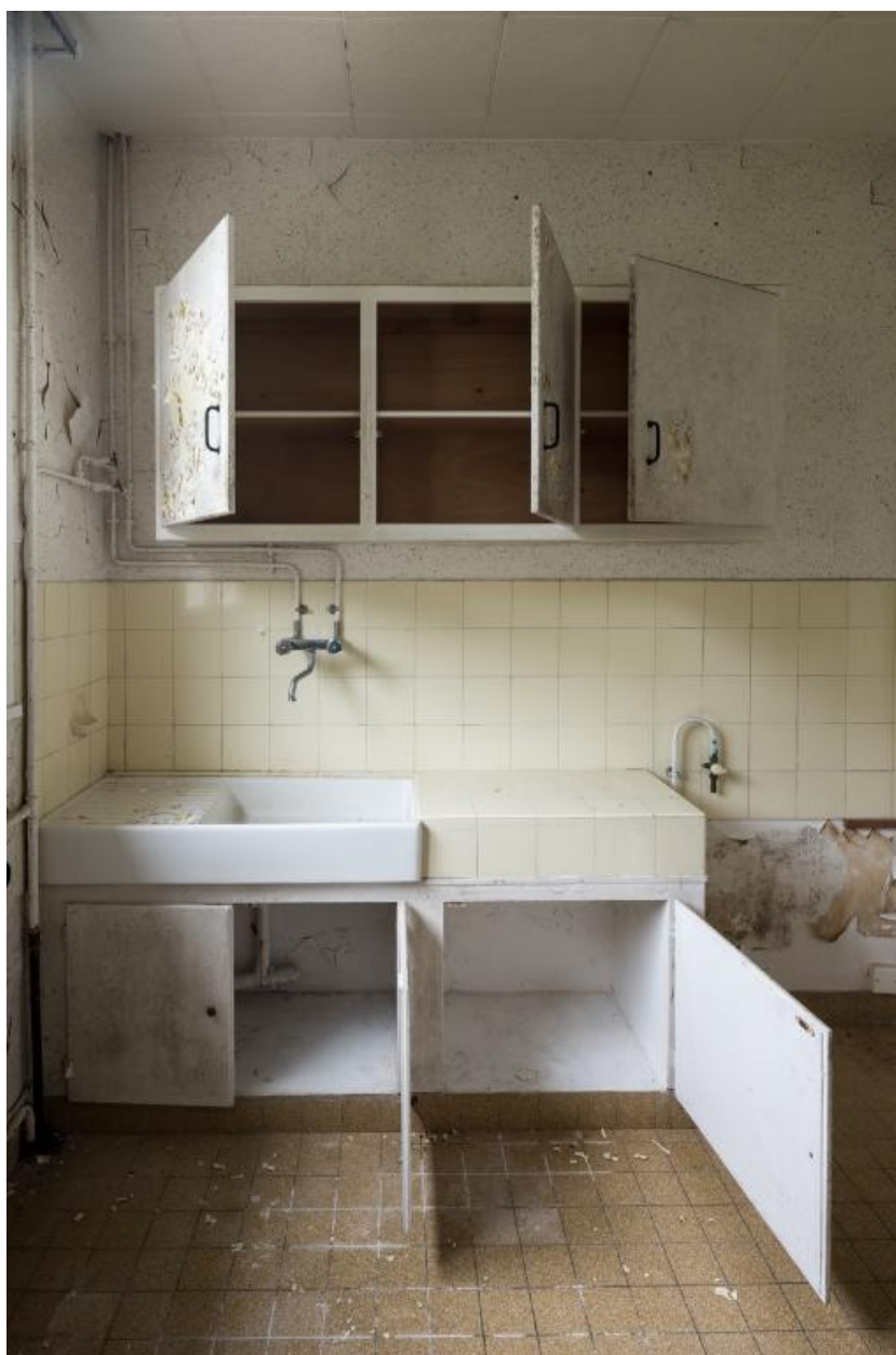
Cuisine dans un logement désaffecté.
