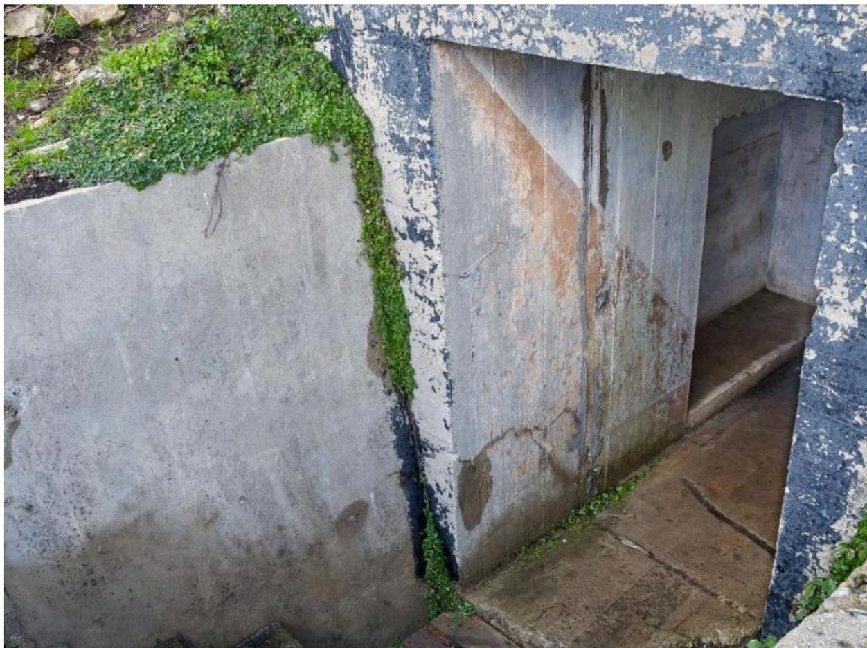
Vue du bunker - abri de type VF 1b pour 6 hommes : entrée sud-ouest précédée d'un escalier. De part et d'autre du passage d'entrée, peinture murale à usage de camouflage (teinte ocre)
