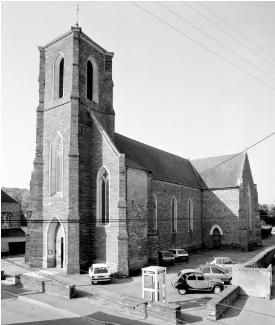
Elévation Nord-Est : vue générale
