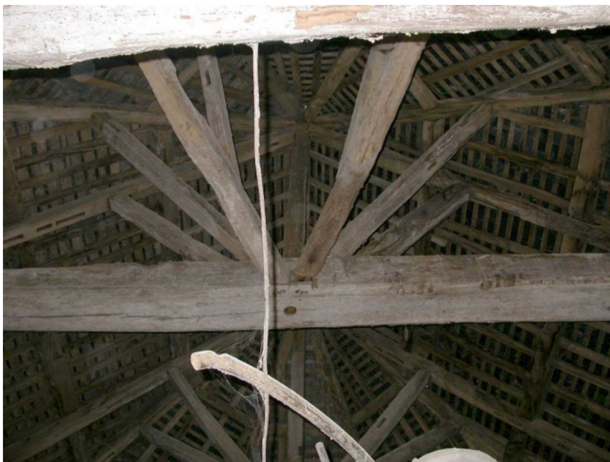
Charpente du pigeonnier
