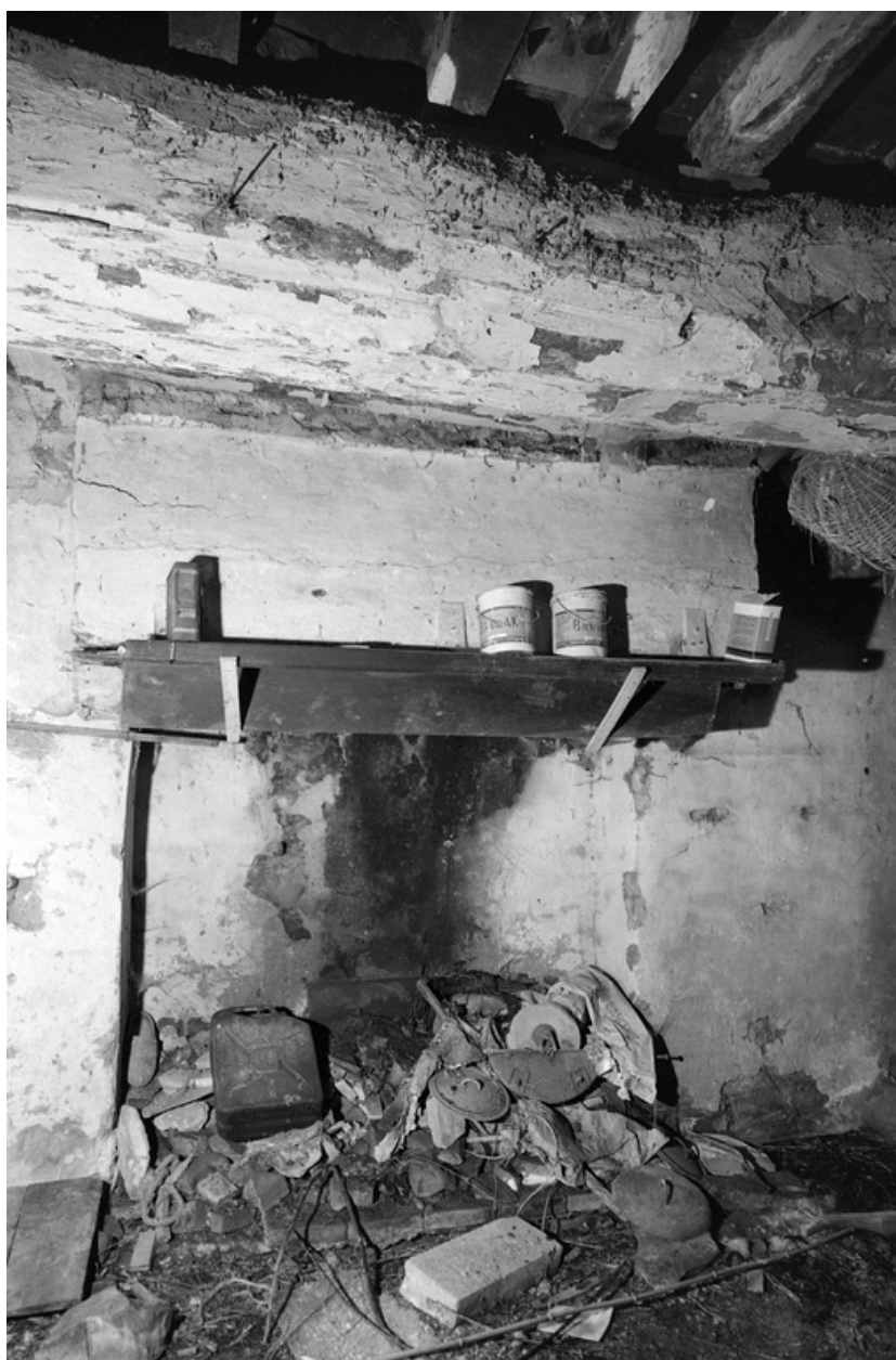
Cheminée, vue générale.
