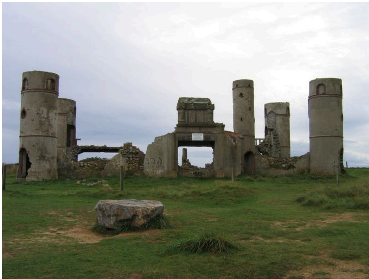
Vue d'ensemble des vestiges du manoir de Boulτους : ancienne façade ouest
