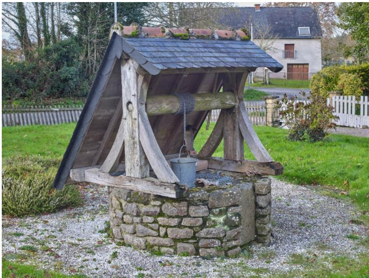
Puits couvert. Vue générale
