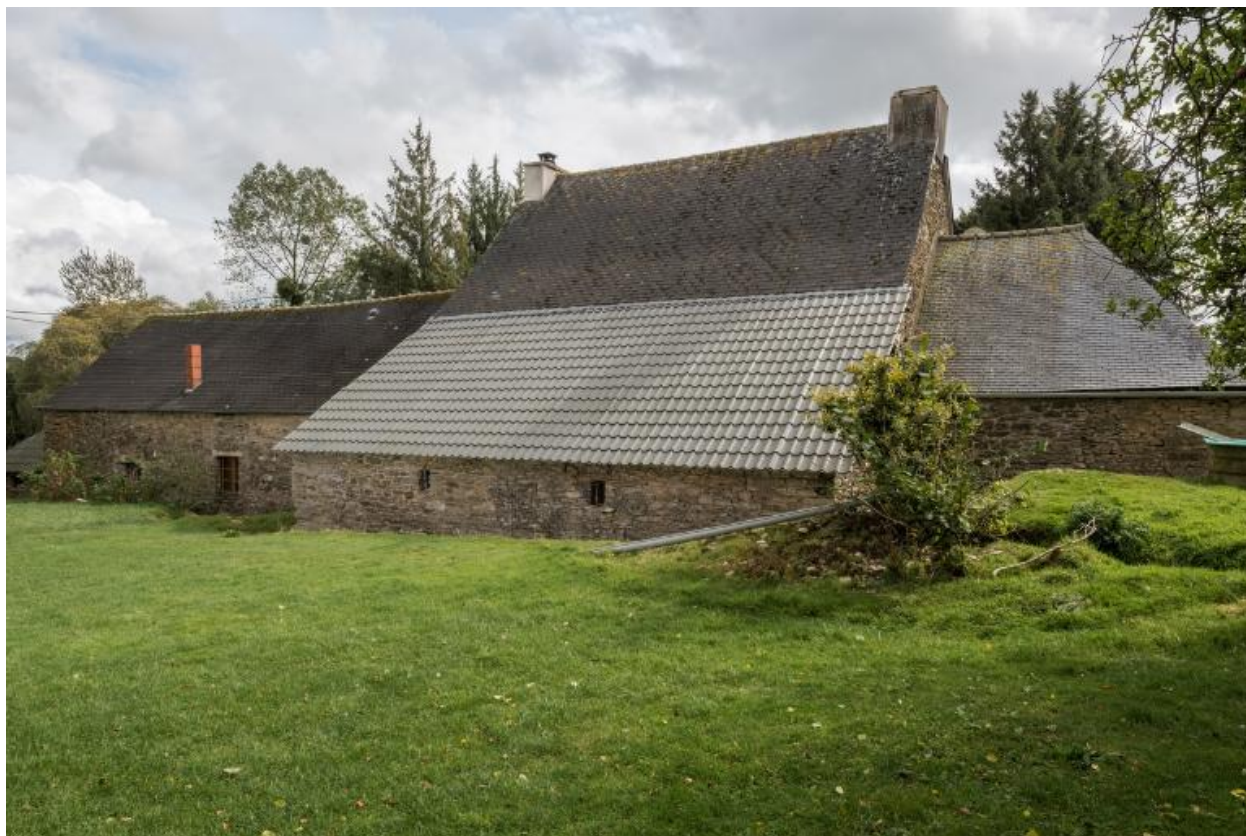
Logis 1774. Appentis à étage. Vue générale nord-ouest
