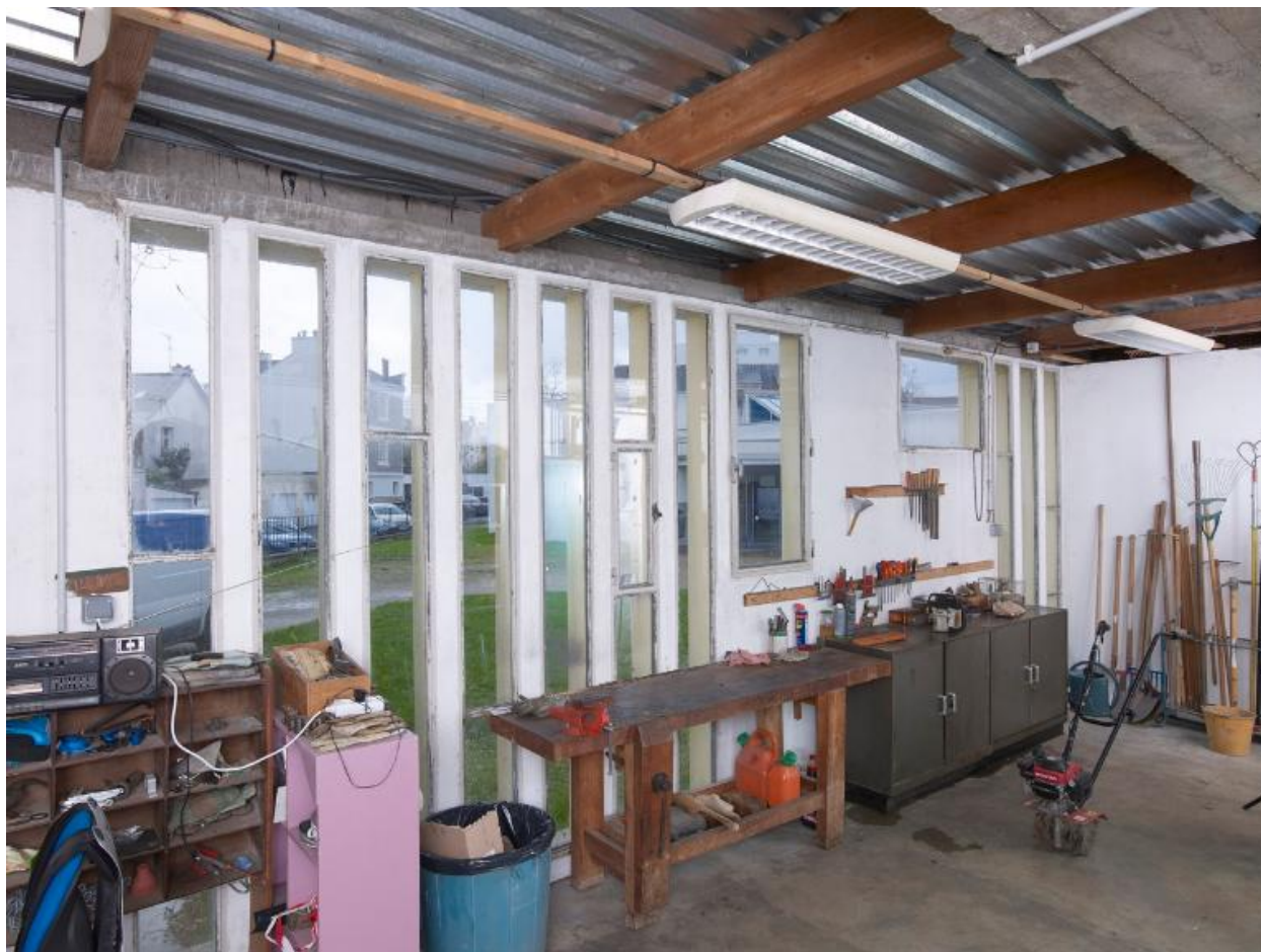
Chapelle, vue intérieure de la sacristie, aujourd'hui à usage d'atelier. René Ouvré architecte (1966-1967).
