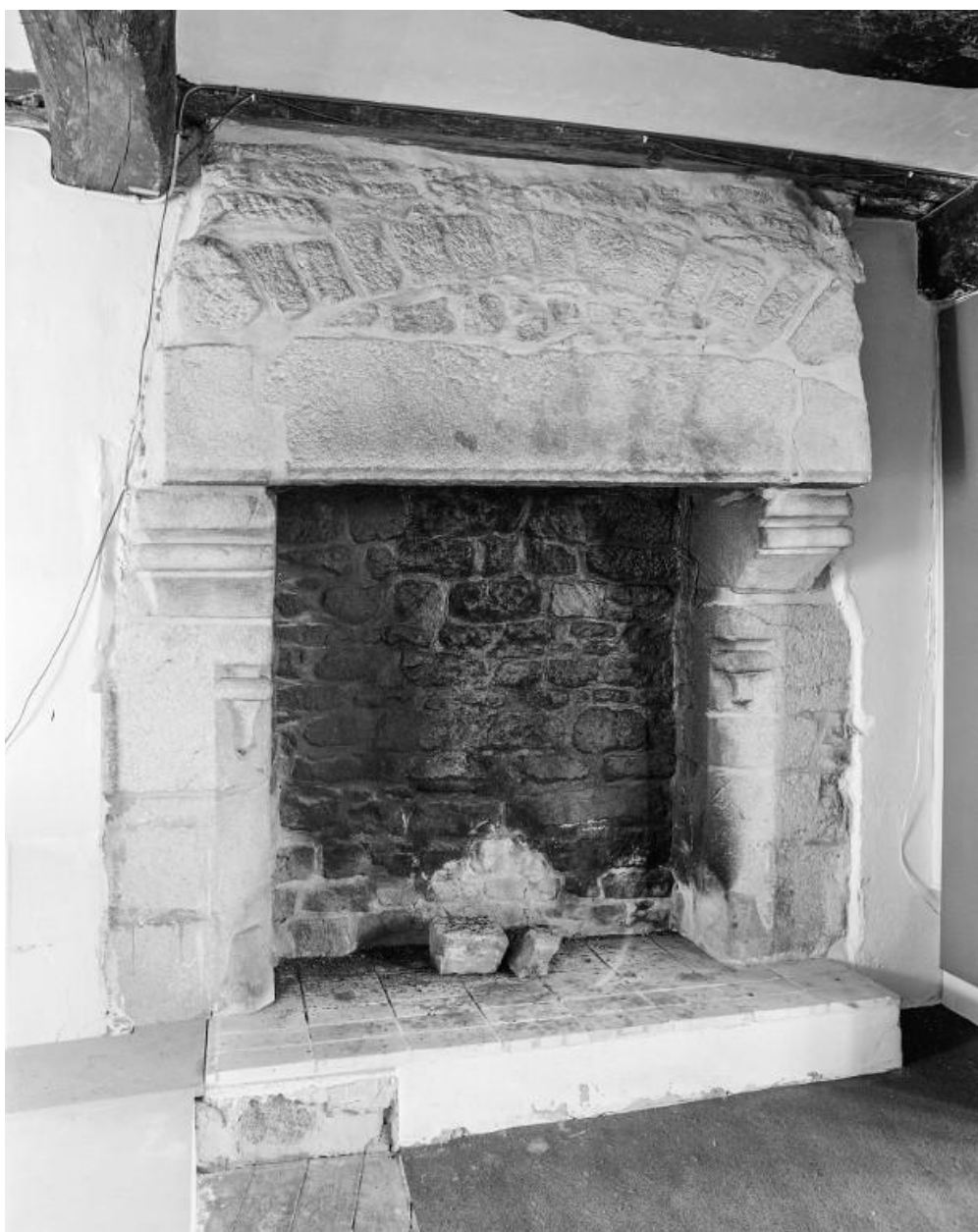
Cheminée au premier étage (état en 1978).
