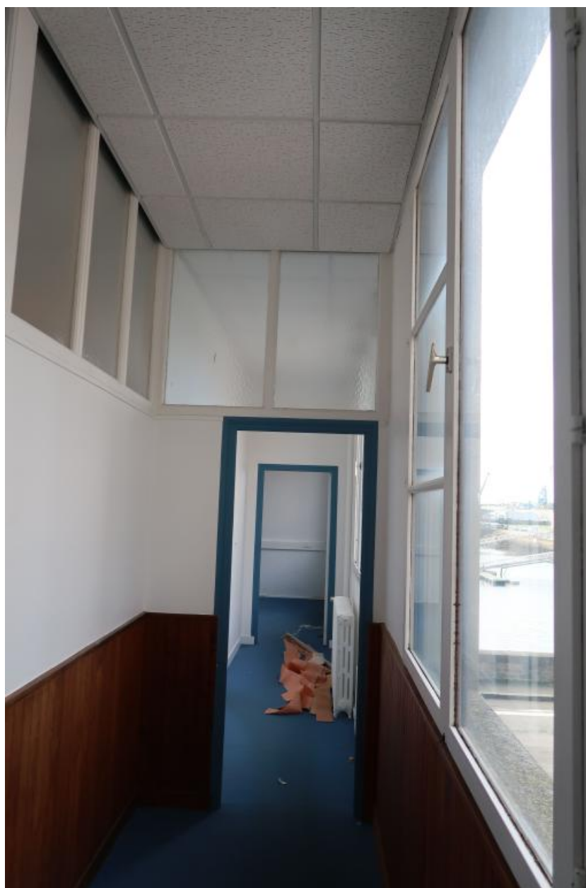
Intérieur, 1er étage, couloir
