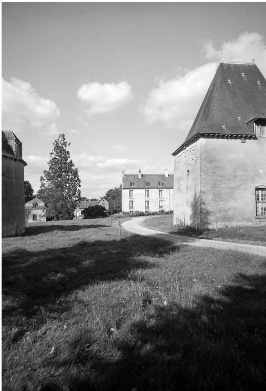
Vue de situation, prise du sud-ouest.
