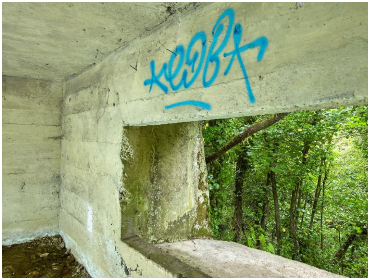
Vue de l'embrasure rectangulaire depuis l'intérieur de la chambre de tir
