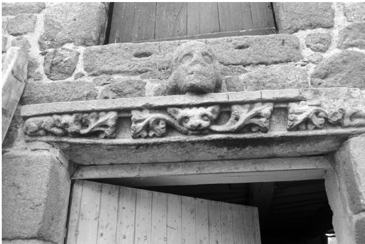
Linteau de la porte de la grange
