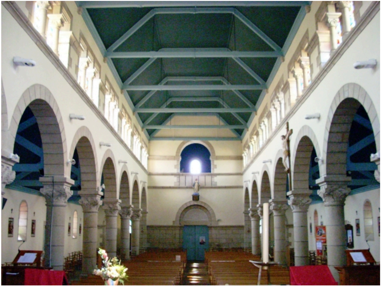
Plomelin, église paroissiale : vue axiale ouest
