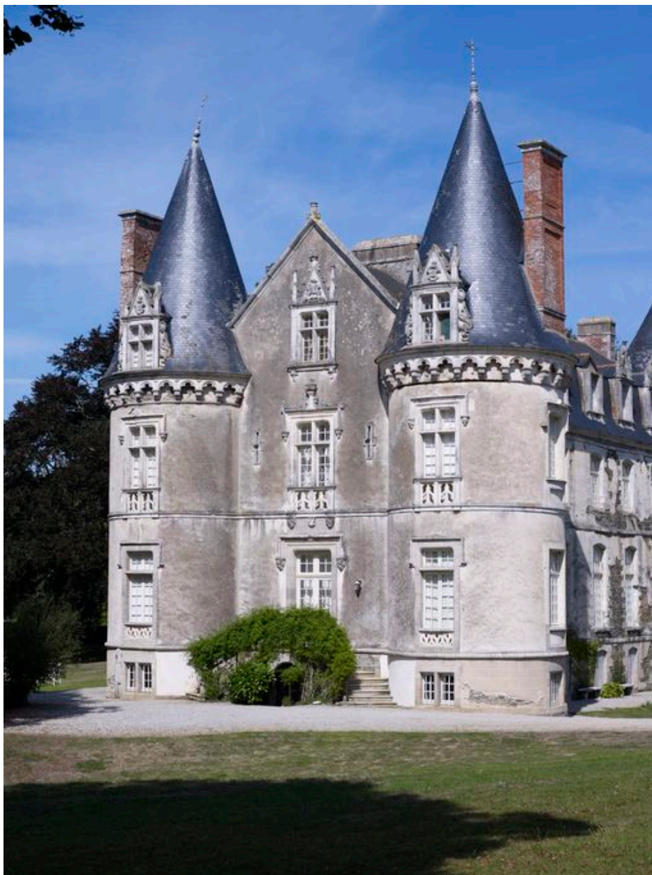
Château, logis : élévation ouest (état en 2010)
