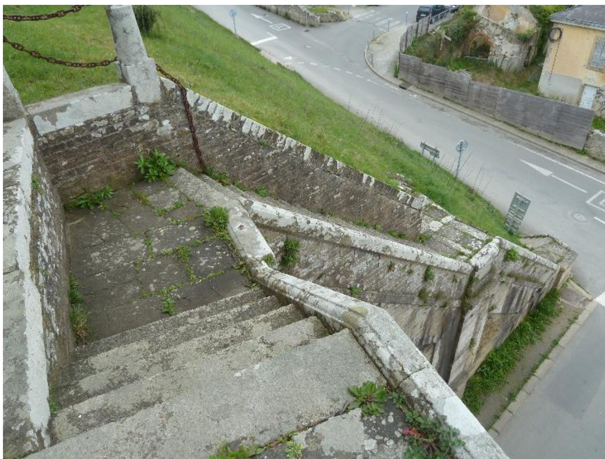
Le Palais, enceinte urbaine, porte Vauban, escalier droit.
