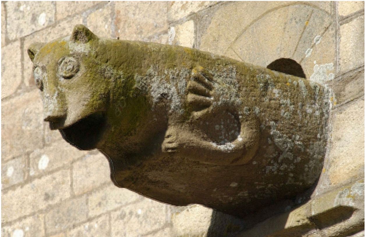
Façade sud, détail, gargouille d'un contrefort
